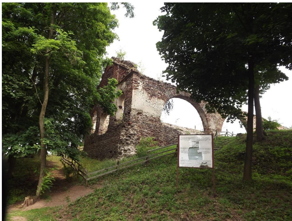
Fotografia 4 Ruiny Zakładu Wielkopiecowego w Bobrzy (widok od ul. Staszica)
