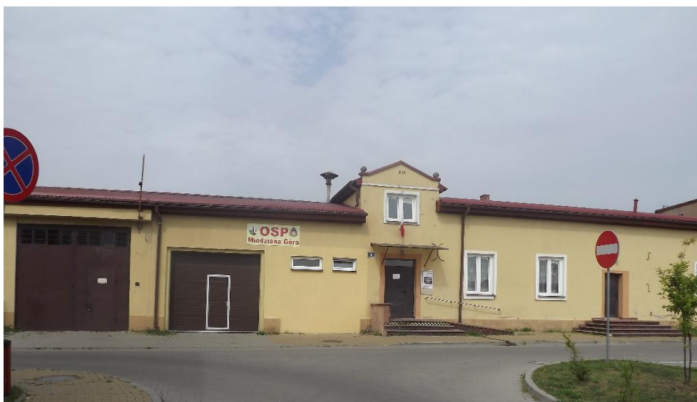
Fotografia 1 Budynek Ochotniczej Straży Pożarnej w Miedzianej Górze
