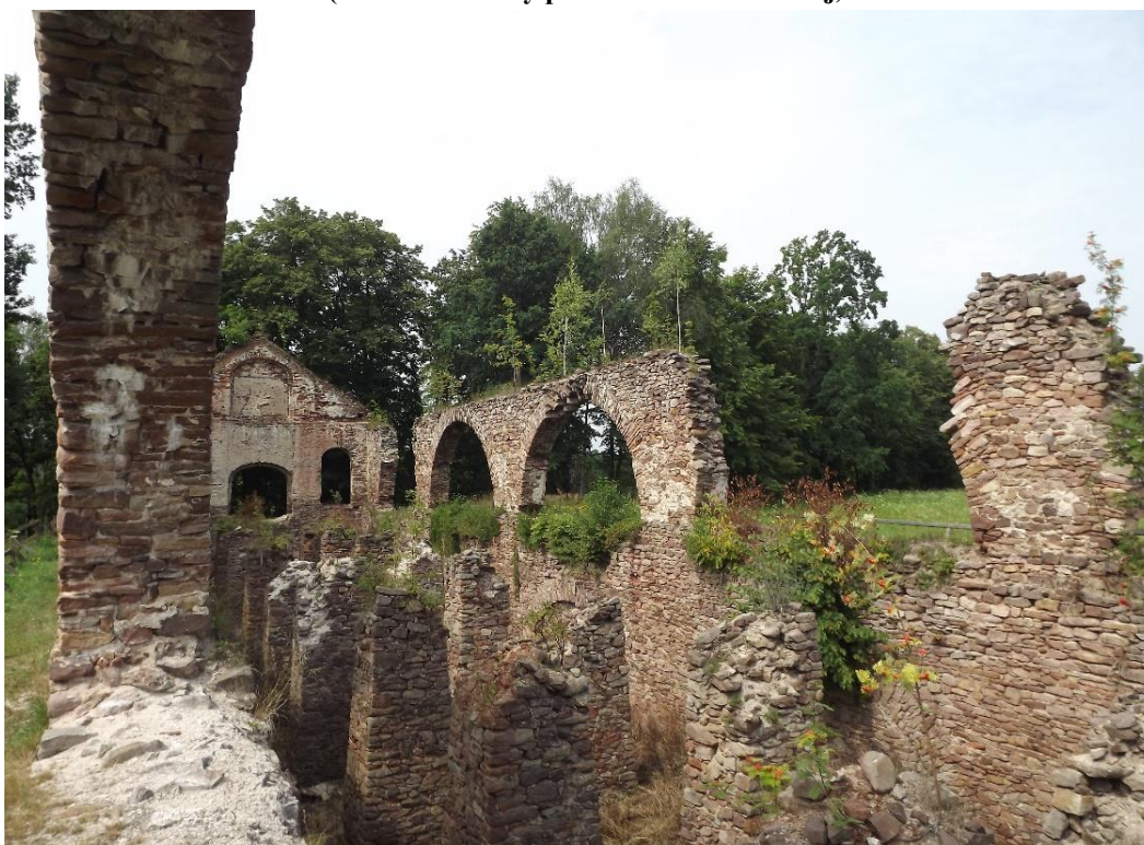
Fotografia 10 Ruiny Zakładu Wielkopieczowego w Bobrzy – węgielnia (widok od strony południowo-zachodniej)
