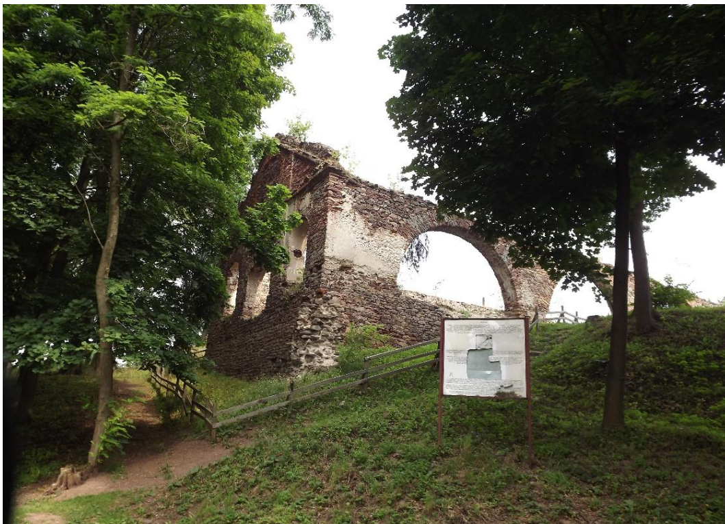
Fotografia 9 Ruiny Zakładu Wielkopieczowego w Bobrzy (widok od ul. Staszica)
