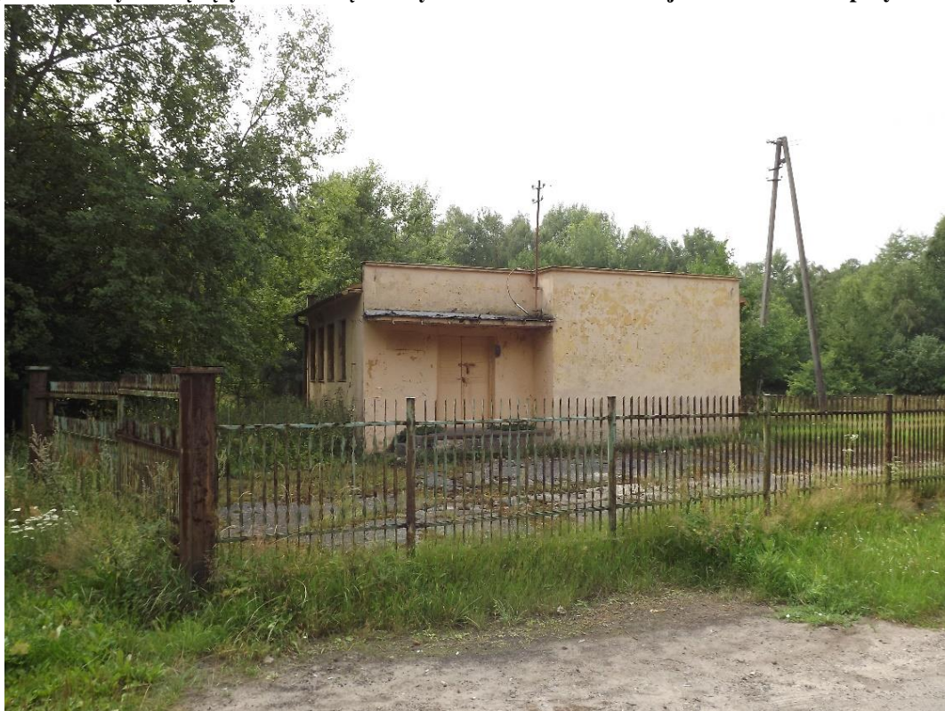
Fotografia 7 Budynek będący własnością Gminy Miedziana Góra w miejscowości Bobrza przy ul. Staszica
