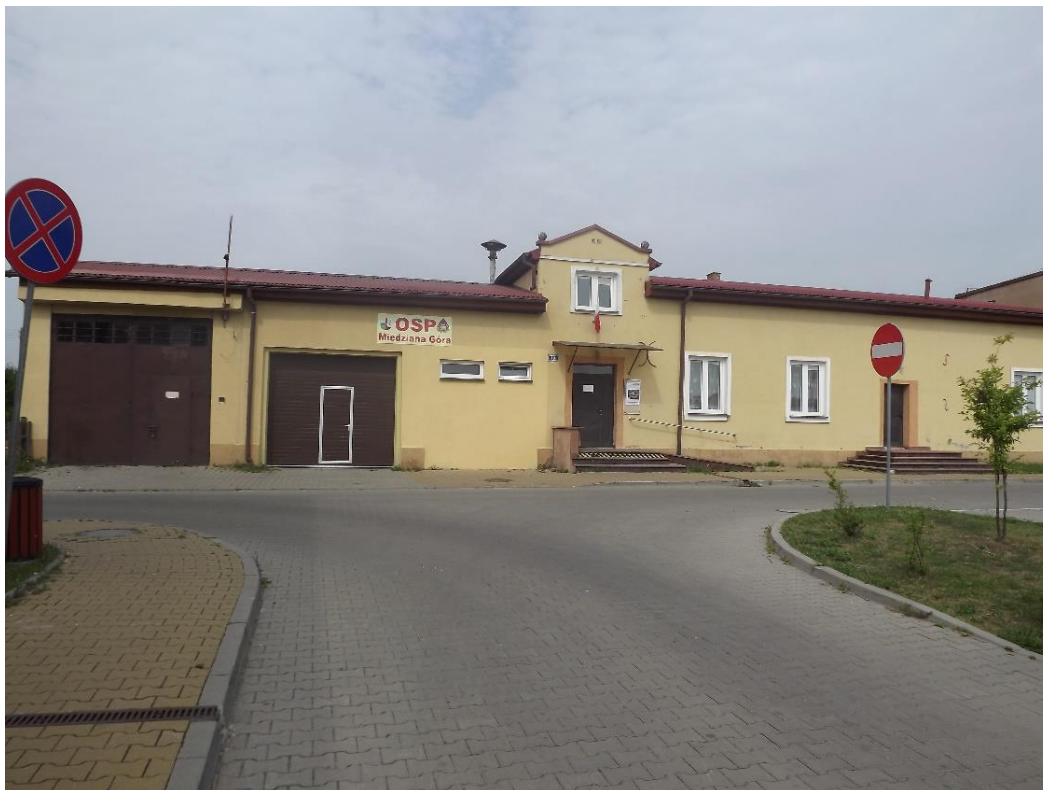
Fotografia 1 Budynek Ochotniczej Straży Pożarnej w Miedzianej Górze
