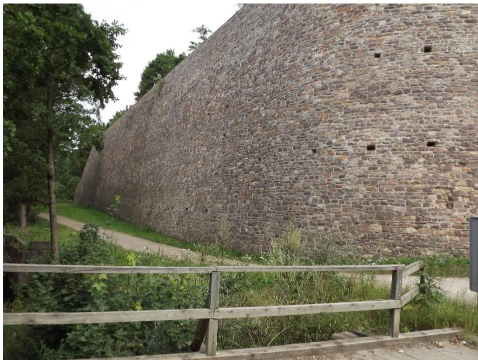
Fotografia 3 Zabytkowy Mur Oporowy Zakładu Wielkopiecowego w Bobrzy
