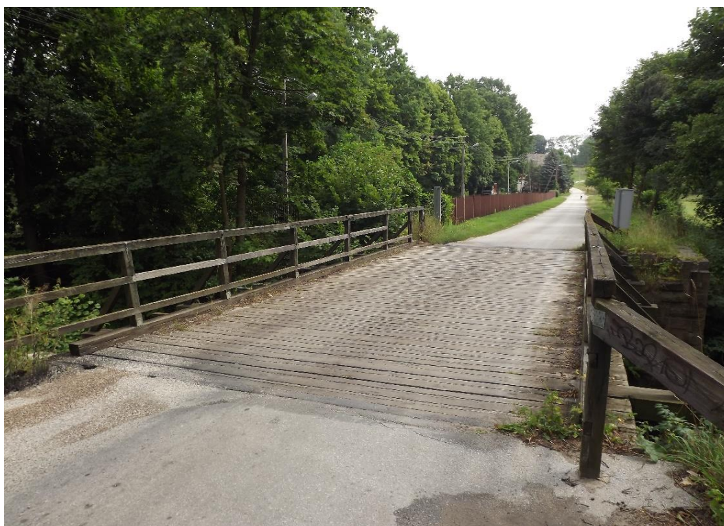
Fotografia 6 Drewniany most na ul. Staszica w Bobrzy (zdjęcie od strony zabytkowego Muru Oporowego)
