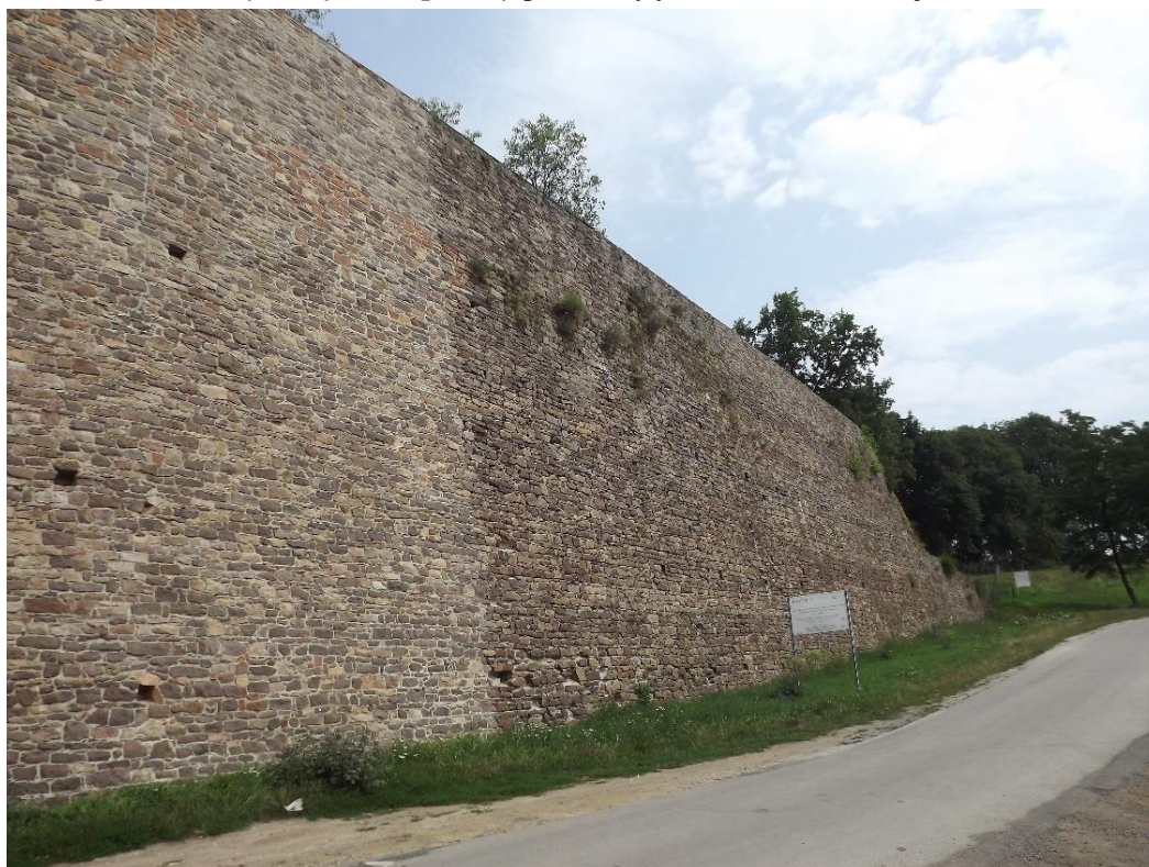
Fotografia 8 Zabytkowy mur oporowy pochodzący z XIX wieku w miejscowości Bobrza
